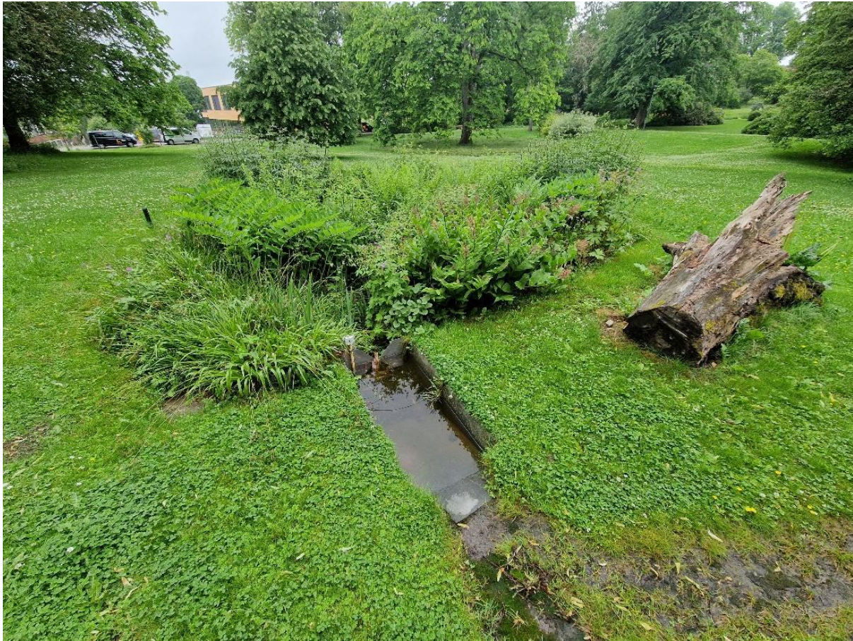
Figur 6: Eksempel på et regnbед. Her ledes vannet fra taket av et bygg via åpne, naturlige renner ned til regnbedet. Supplert med død ved for å skape levested for insekter, sopp og lav. Bildet er fra campus på NMBU, og er tatt av Rebekka Sundøy Haldorsen.
