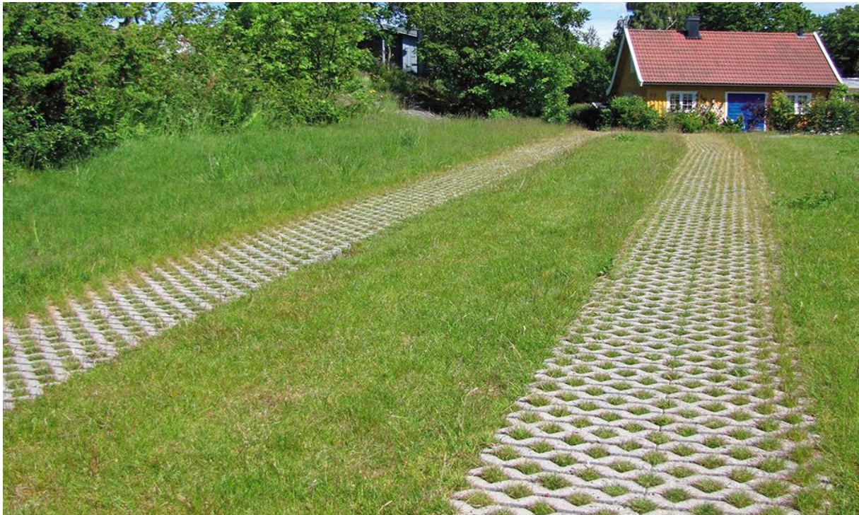
Figur 13: Bildet illustrerer bruken av gressarmering på feltene hvor bildekkene treffer bakken. Dette kan benyttes over en hel parkeringsplass. Bildet er hentet fra www.hmhcement.no . Dersom man tilfører sand og sår i frøblandinger av blomstereng (fortrinnsvis NIBIOs frøpakke for Sørvest-Norge eller egensanket frøkombinasjon) vil det vokse til partier med blomstereng i de arealene som får minst slitasje fra biler og folk. Da legger man til rette for et matfat for insektene og overvannshåndtering.
