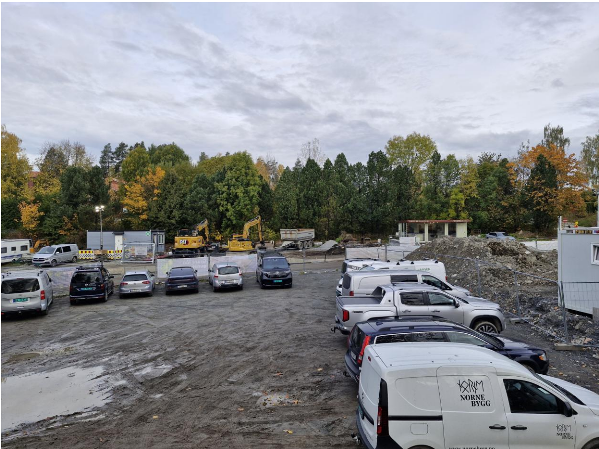
Figur 5: Store deler av området er asfaltert eller gruset, men i randsonene vokser det variert vegetasjon av både hjemlige arter og fremmede arter. Foto: Geir Håvard Liengen.
