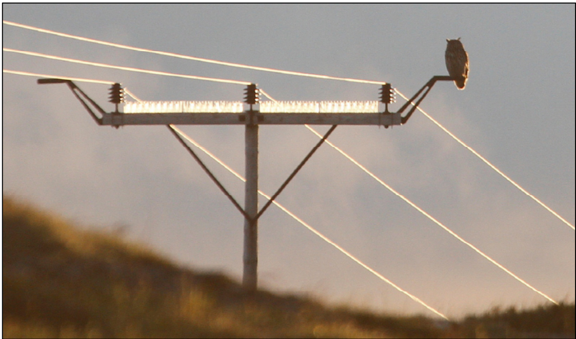
Figur 2. Hubro som sitter på en påmontert sittepinne på en stolpetraverser. Den nyutviklede sittepinnen vil bidra til å redde livet til mange hubroer. Foto: Jan Ove Gjershaug/NINA.
