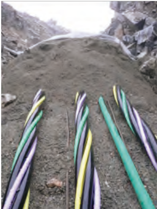
Jordkabel i grøft
