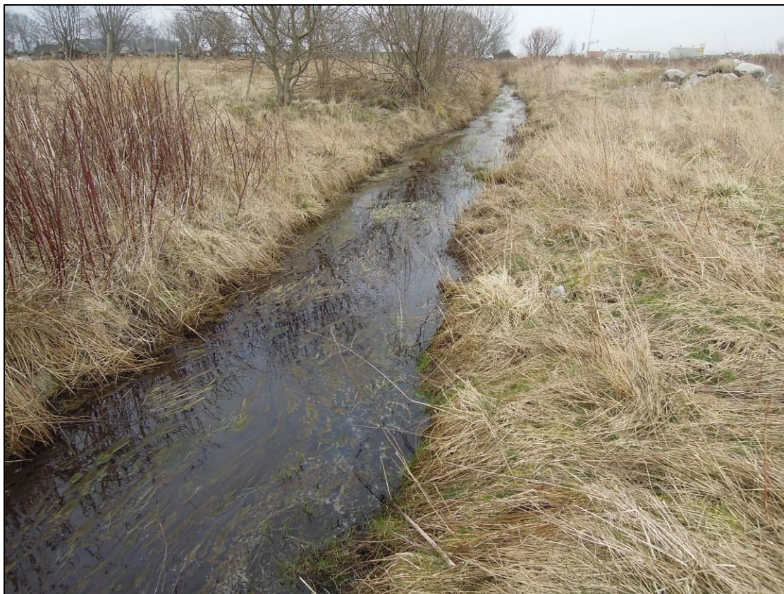
Bilde 7.2. Utløpskanal i øst. Kanalen er vid og sveller unna vannmengdene som kommer trass i trange rør under vei, nedstrøms myra.
