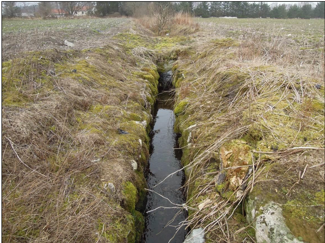
Bilde 7.1. Utløpskanal i sør. Kanalen er smal men sveller unna vannmengdene som kommer.
