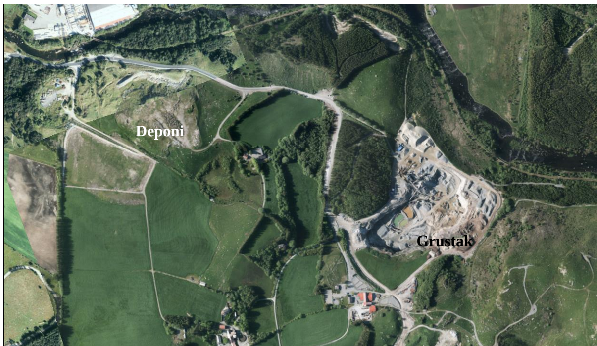
Figur 3.17: Grustaket på Nordre Kalberg (øst) driftes i dag. Deponiet helt nordvest i bildet er ikke lenger i drift, og er under avslutning.
