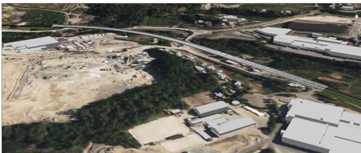
Figur 1.20: Viadukten ved Foss-Eikeland er en lang bro.
