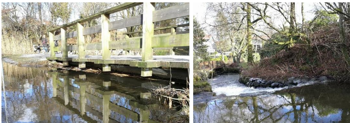
Figur 6.10. Gang- og sykkelbruen ved utløpet av dammen i Sandvedparken (t.v) og terskelen nedstrøms dammen
