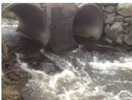
Rørene under Melsheiveien
