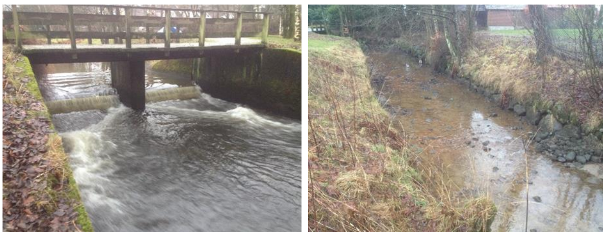
Figur 11.2. Til venstre: Terskel ved Brueland mellom sone 7 og 8 som danner vandringshinder (hinder 1) med unntak av ved flom. Til høyre: Sideløp (9) ved Brueland der trelem (hinder 2) regulerer vanntilførsel og fungerer som vandringsstengsel i øvre del.
