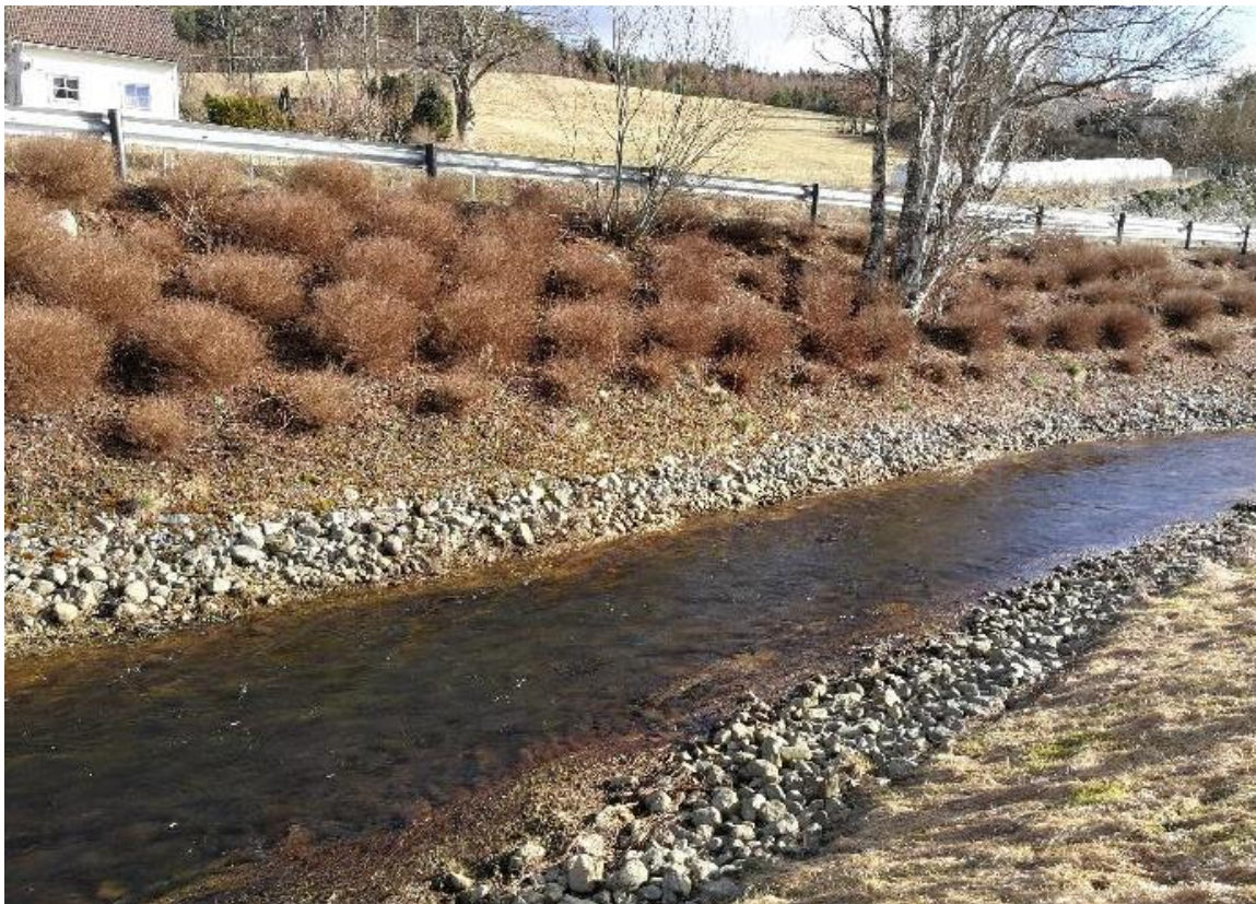
Figur 6.18. Langs elvestrekningen ved Brattbø gir liten variasjon i bunnsubstatet stor vannhastighet
