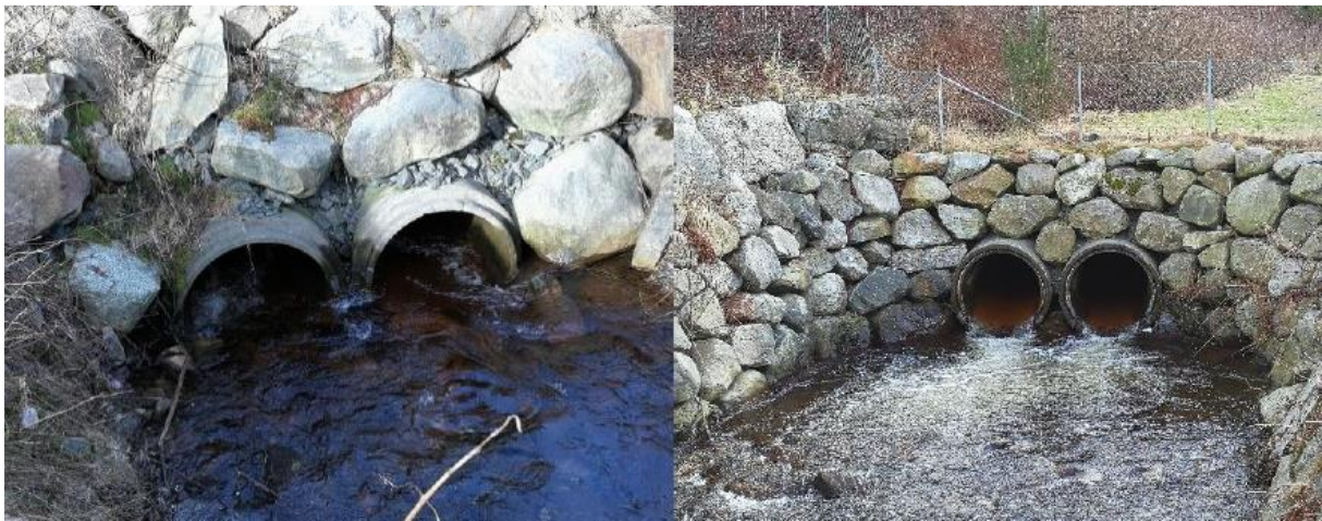
Figur 6.19. Utløpet av den 40 meter lange kulverten (t.v) og innløpet til kulverten under E39 (t.h.)
