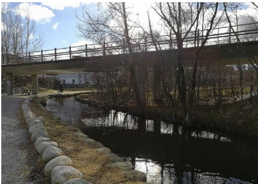
Figur 6.11. Høyt vannstand i Storåna oppstrøms dammen i Sandvedparken
