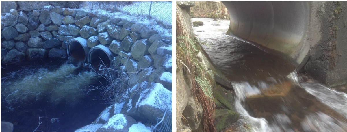
Figur 11.5. Til venstre: Hinder 7 ved Bjønnbåsen i sone 30. Rør som danner vandringsstengsel. Til høyre: Vandringshinder under Melsheiveien. Flat betongkonstruksjon nedstrøms bro danner lav vannsøyle med sterk strøm, og vanskeliggjør passasje både for større og mindre fisk.
