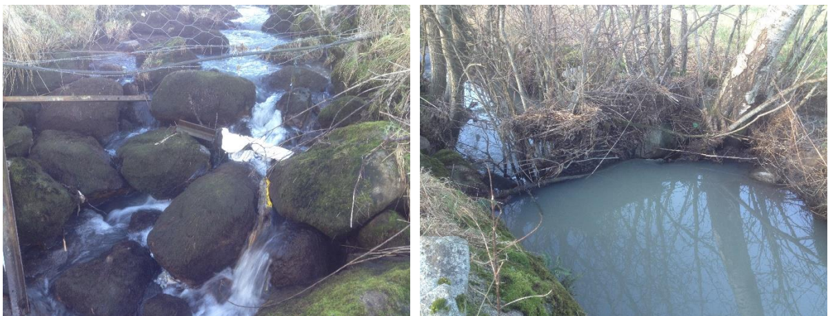
Figur 11.7. Til venstre: Vandringshinder 1 i sone 3. Til høyre: Vandringshinder 2 skyldes trær og oppsamling av diverse materiale som stenger løpet. Tilslamming som følge av gravearbeid viser godt, det ble målt en turbiditet på 109 FNU på befaringen.
