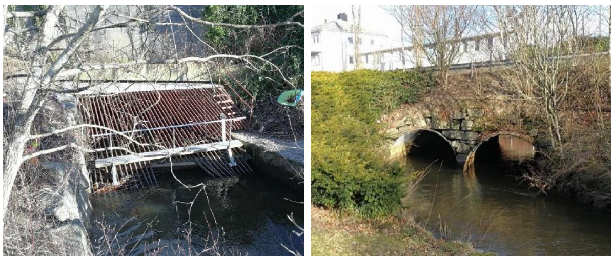
Figur 6.9. Risten foran jernbanekulverten (t.v) og kulverten under Ganddalsgata (t.h.)
