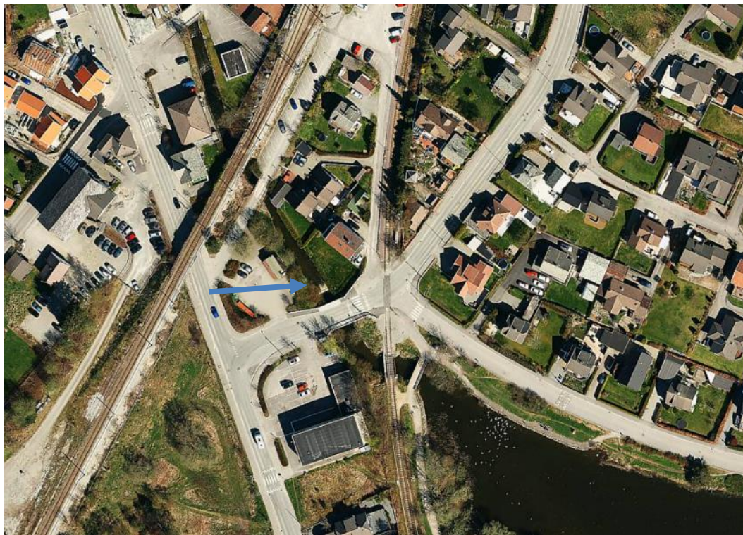
Figur 6.14. Flybilde som viser utløpet fra Stokkalandsvatnet og plasseringen av dagens betongterskel (ved blå pil)
