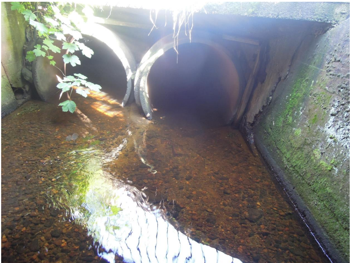
Figur 22. Gytegrus nedenfor nederste kulvert i Fardalsbekken. Inne i selve kulverten er det fine substrat og gyteforhold for smålaks og sjørret. Foto: Rune Søyland
