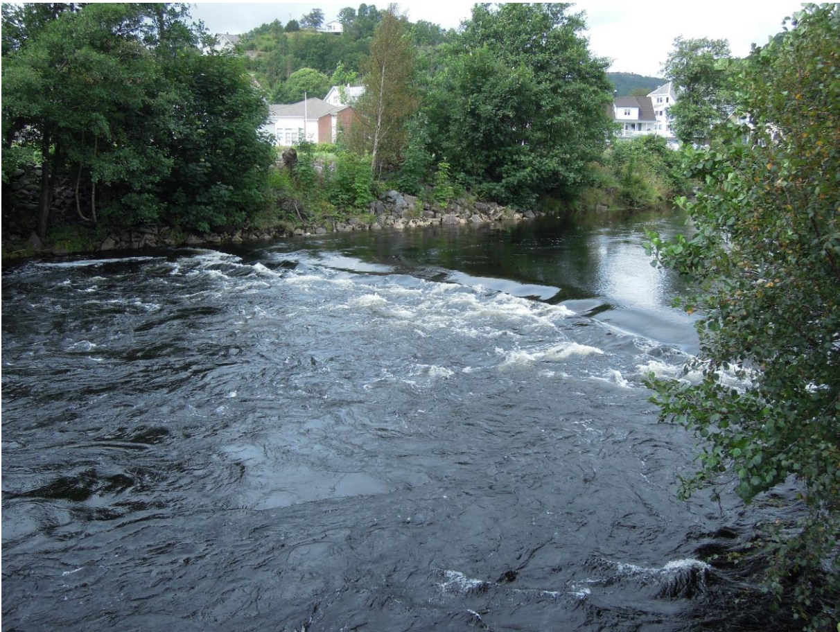
Figur 15. Terskel nedstrøms svingen ved «Sparbygget». Foto: Leif Appelgren
