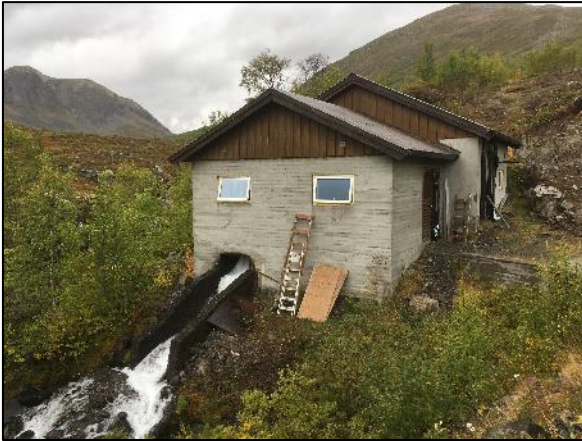
Figur 7. Eksisterende kraftverk i Hestbekken, Foto: Bjarne Homnes Oddane
