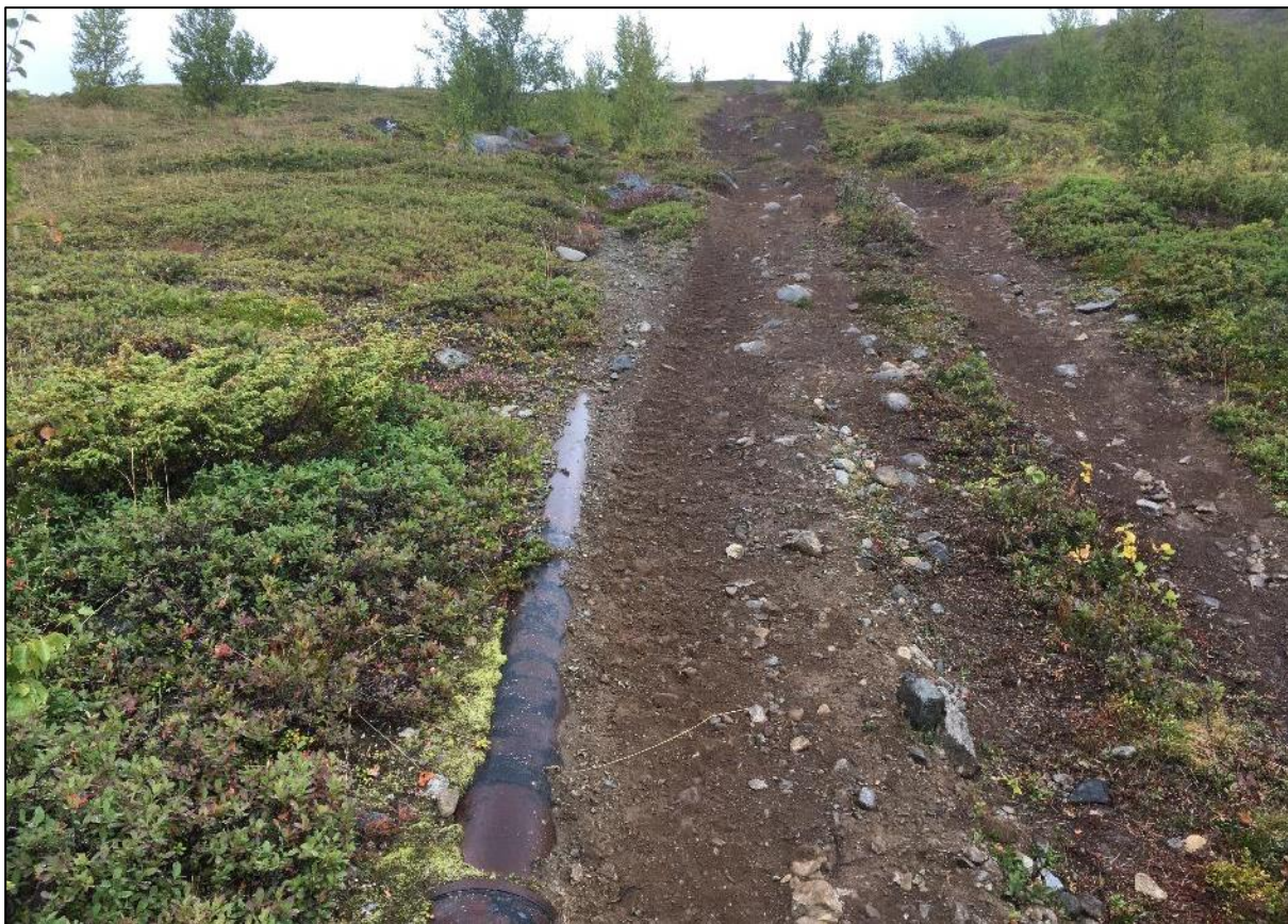
Figur 4. Eksisterende rørgate går i stor grad lang eller i nærheten av en traktorvei fra kraftstasjonen til inntaket. Foto: Bjarne Homnes Oddane
