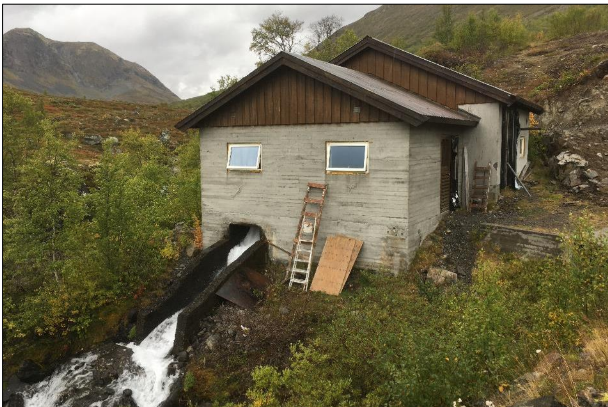
Figur 5. Eksisterende kraftstasjon. Foto: Bjarne Homnes Oddane
