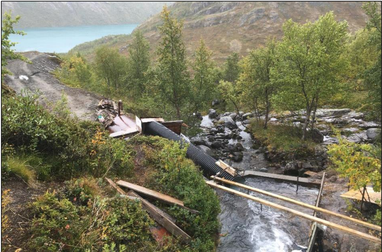
Figur 3. Eksisterende inntak i Hestbekken. Foto: Bjarne Homnes Oddane
