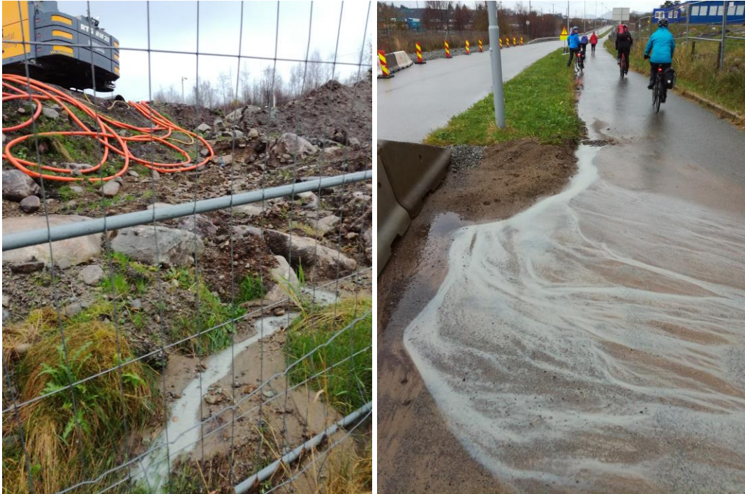
Figur 2: Fullstendige avskjæringsgrøfter rundt riggområdet vil forhindre at avrenning går rett i kum/bekk. Bilder tatt 4. nov.
