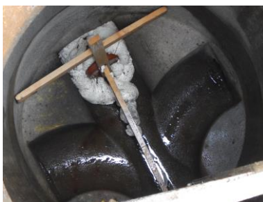
Figur 2. Vannprøven ble tatt fra denne kummen den 25. sep 2017. Kummen ble deretter stengt, og drenerer ikke vann fra riggområdet i dag.
