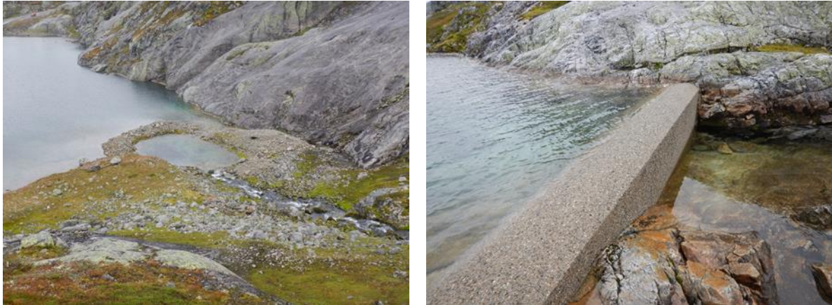
Figur 4.5. Innløpsbekken til det sørlige bassenget(t.v.) og terskelen ved utløpsbekken (t.h.).
