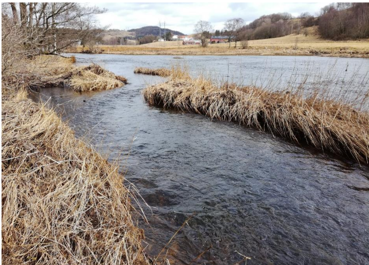
Figur 47. Tiltak 5, steinsetting av det nordlige sideløpet.
