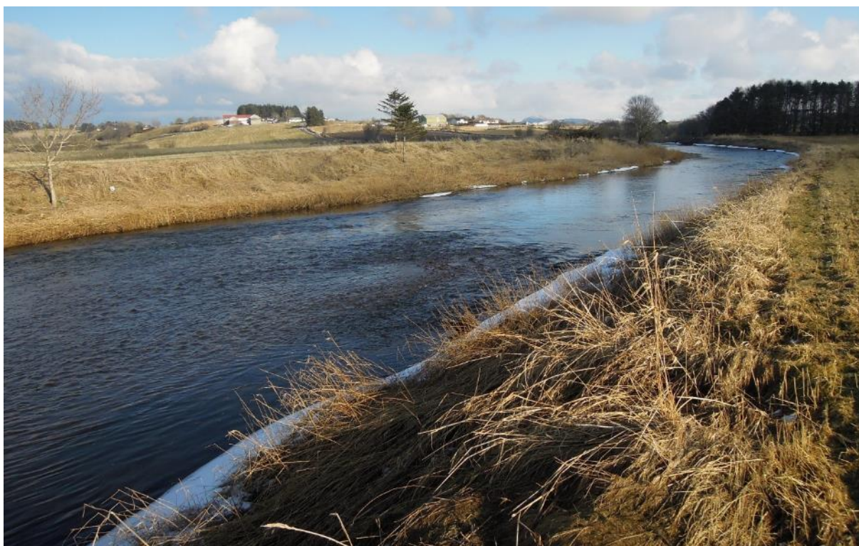
Figur 53. Tiltak 1. Brekk 2 sett mot brekk 1 (i sving).
