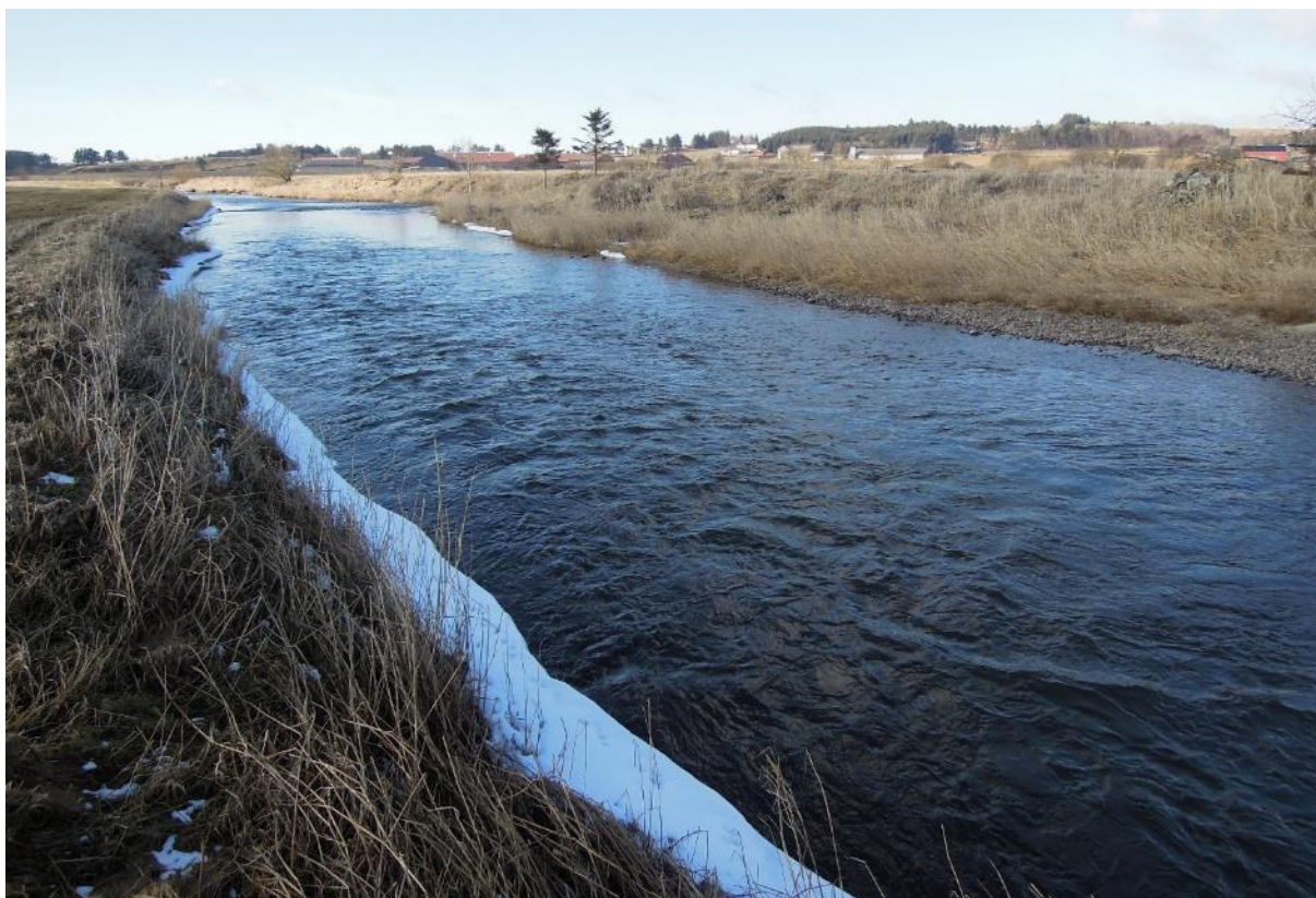
Figur 52. Tiltak 1. Sett fra brekk 1 mot brekk 2.
