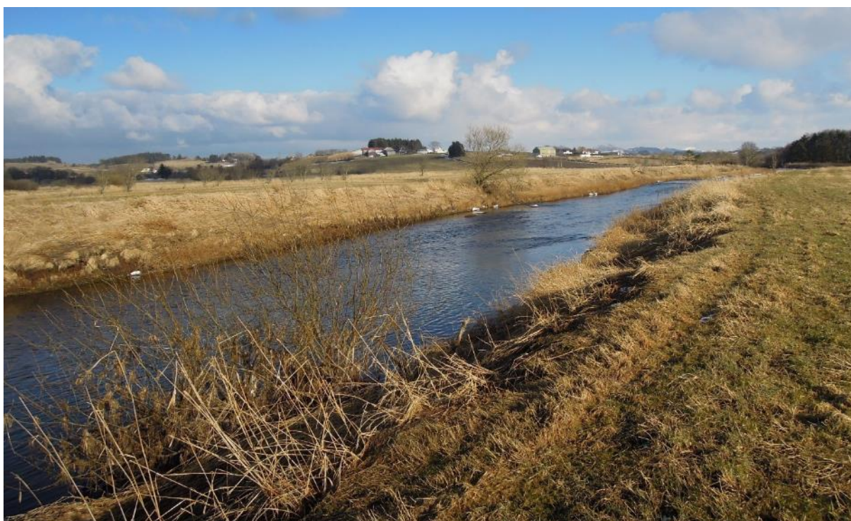
Figur 55. Tiltak 1. Brekk 4, med brekk 3 sett i bakgrunnen.
