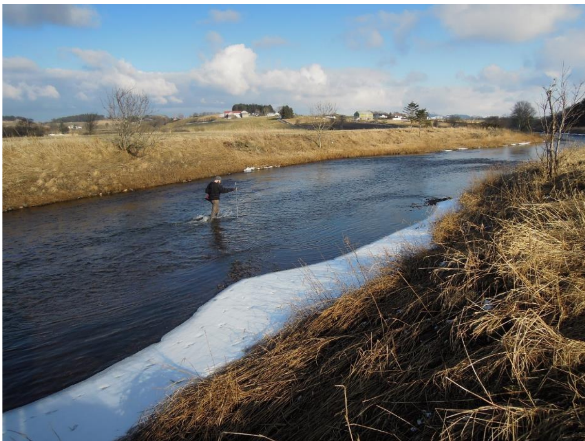
Figur 54. Tiltak 1. Brekk 2 (øverst) mot brekk 3.
