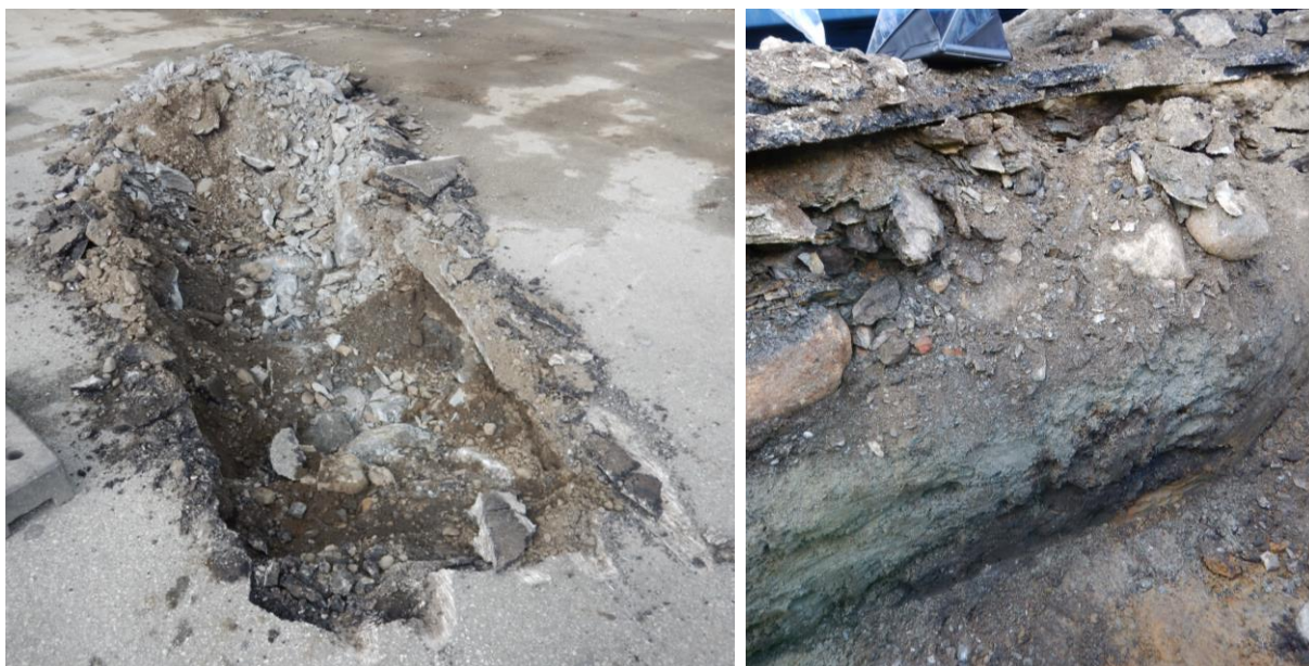
Figur B4. Sjakt G (venstre) og H (høyre).
