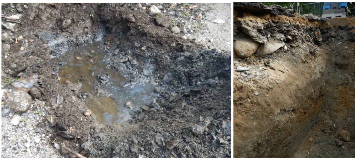
Figur B5. Sjakt I (høyre) og J (venstre).
