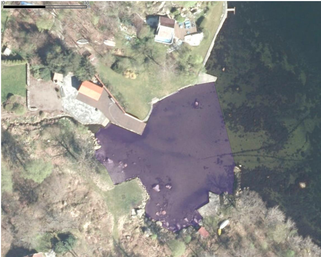
Figur 15. Indre deler av bukta bør mudres for å fjerne tilførte masser.
