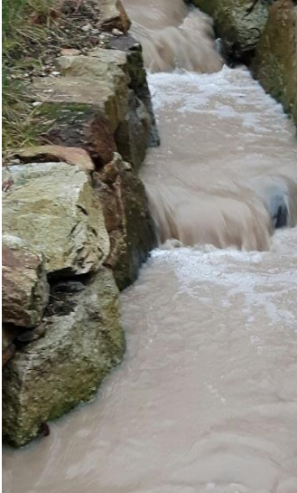
Figur 3. Bekkevannet under anleggsarbeidet. Foto: Bente Elisabeth Skåra.
