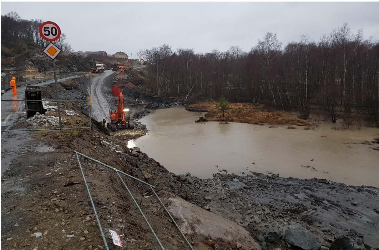
Figur 4. Store nedbørsmengder i anleggsperioden ga utfordringer med masseutskiftingen på myra. Foto: Oppdragsgiver.
