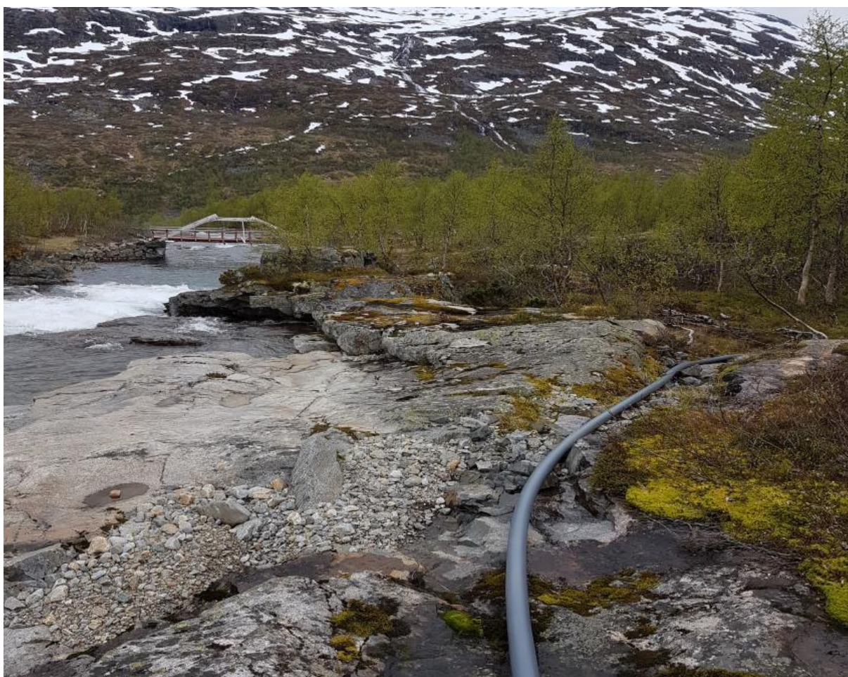
Figur 4. Inntaksområdet sett mot vest. Bru med turiststien sees i bildet. Foto: Kleppconsult AS.
