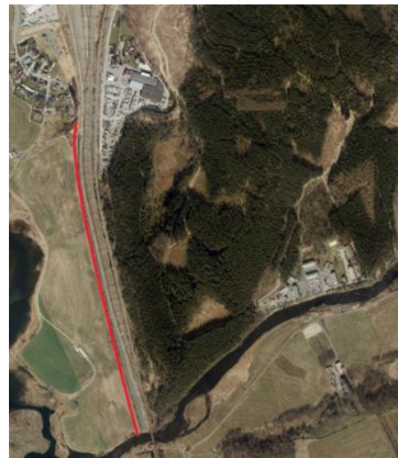
Strekning som bør restaureres
