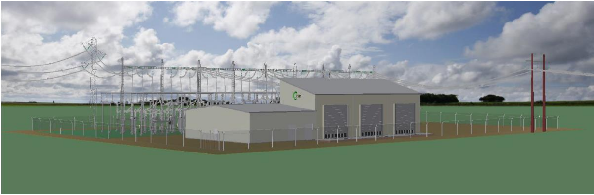
Figur 3.4. Prinsippskisse av utendørs, luftisolert (AIS) transformatorstasjon.
