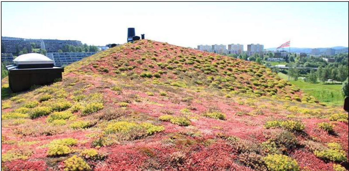
Figur 16. Sedumtak fra Romme skole. Bildet er hentet fra https://www.vegtech.no/gronne-tak--lokk-og-gardsrom/sedumtak---gronne-tak/fotogalleri/
