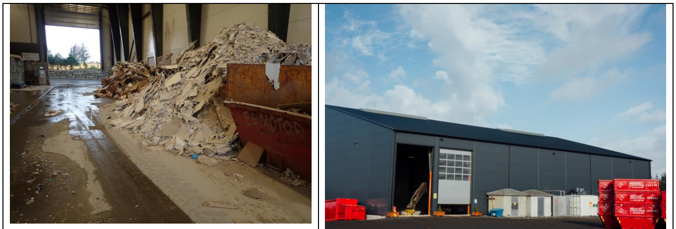
Figur 2.2. Bilder tatt fra dagens anlegg ved Soma.
