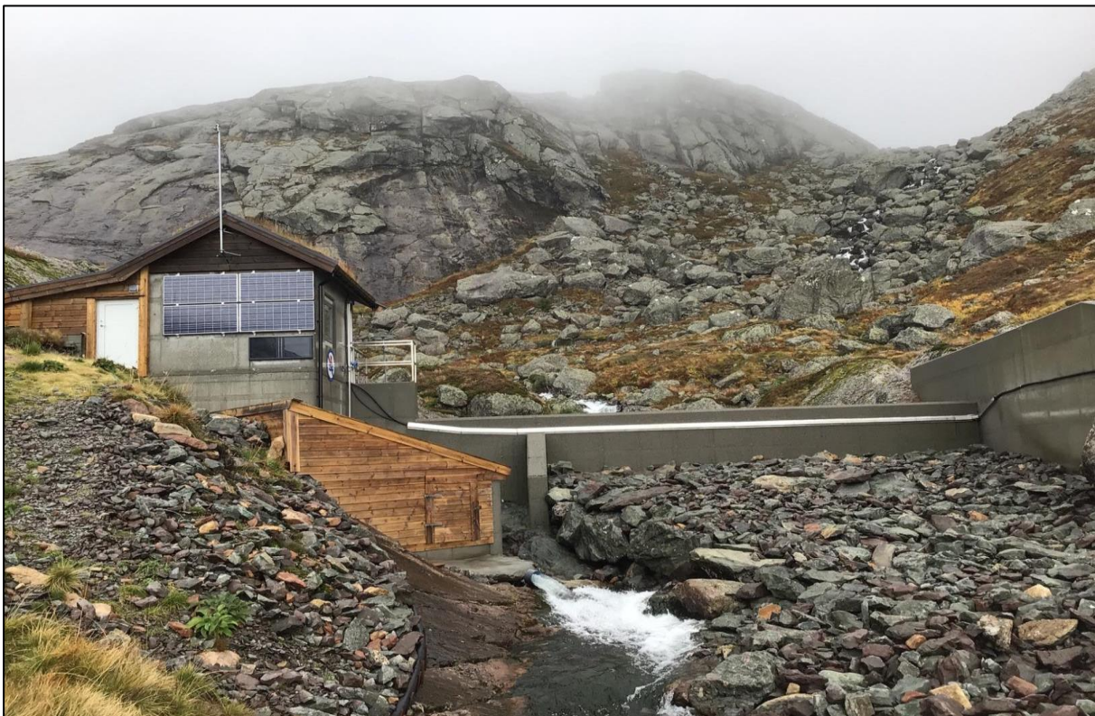
Figur 2.3. Eksisterende inntak for Selselva kraftverk. Foto: Knut Børge Strøm.
