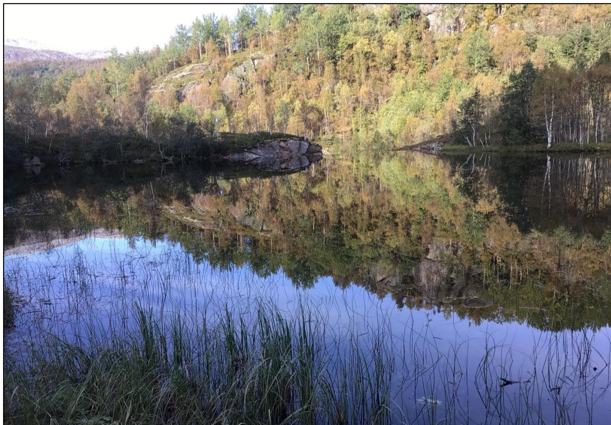
Figur 2.2. Et stort, kunstig vannspeil er etablert i Sørfjordelva som følge av en gamle betongdemning. Foto: Knut Børge Strøm.
