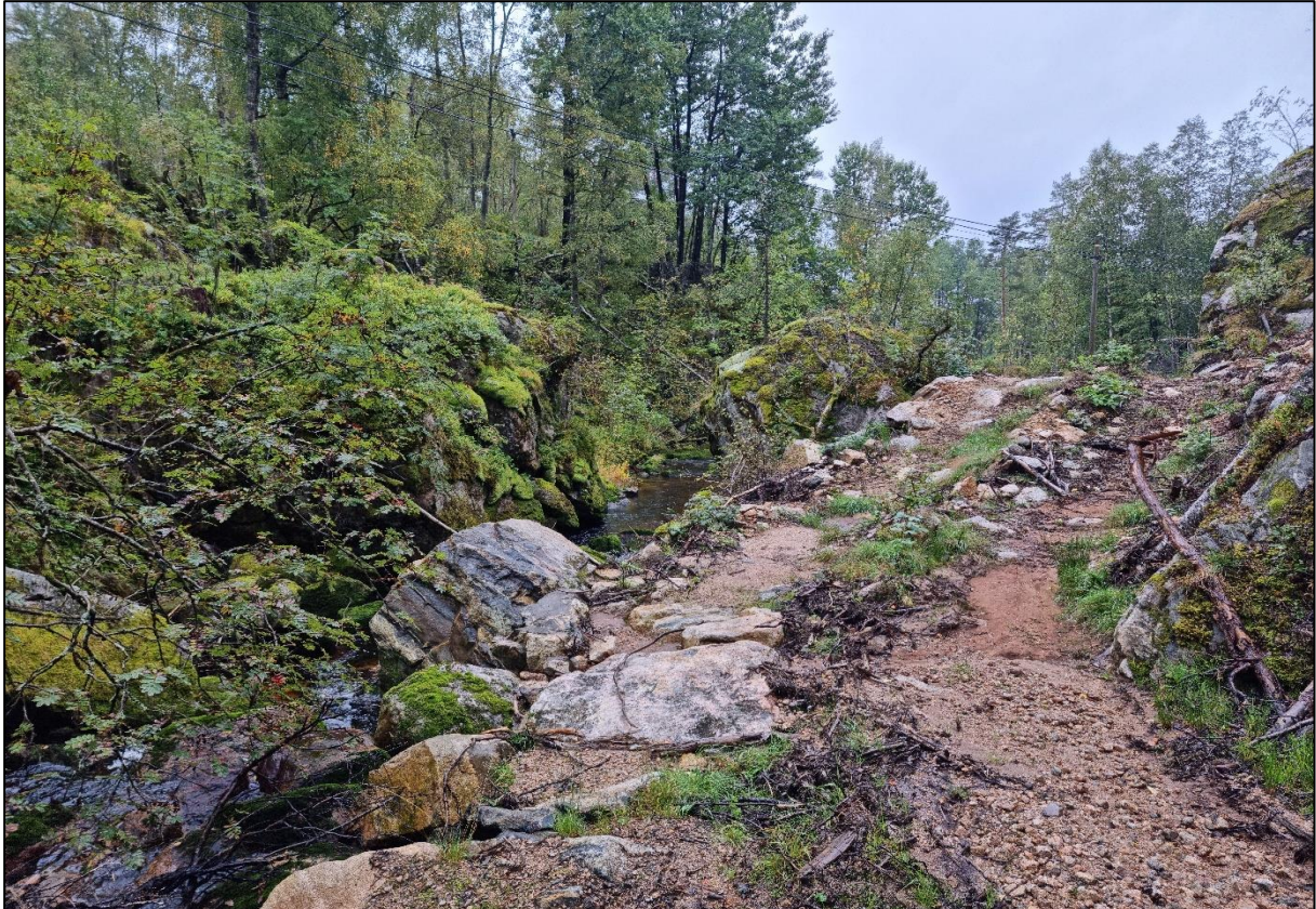
Figur 2.2 Nylig etablert skogsbilvei i direkte tilknytning til Kleivebekken.
