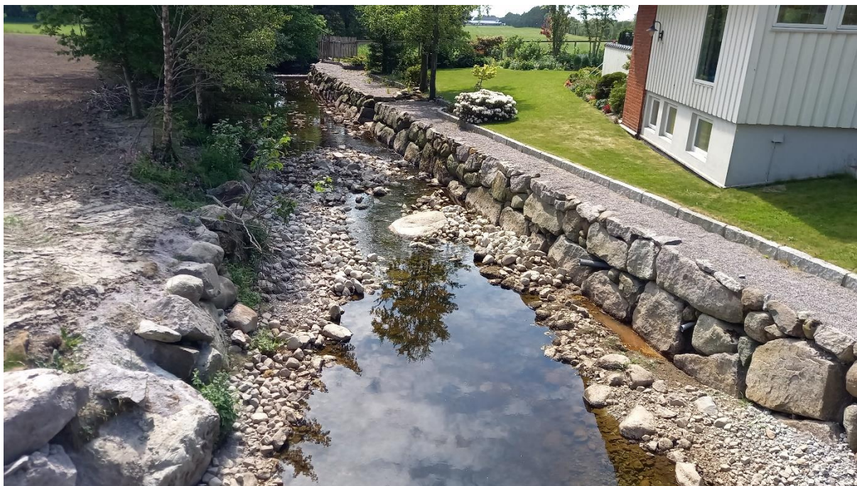
Figur 2-7. Utforming av bekkeløpet nedstrøms ny bru.
