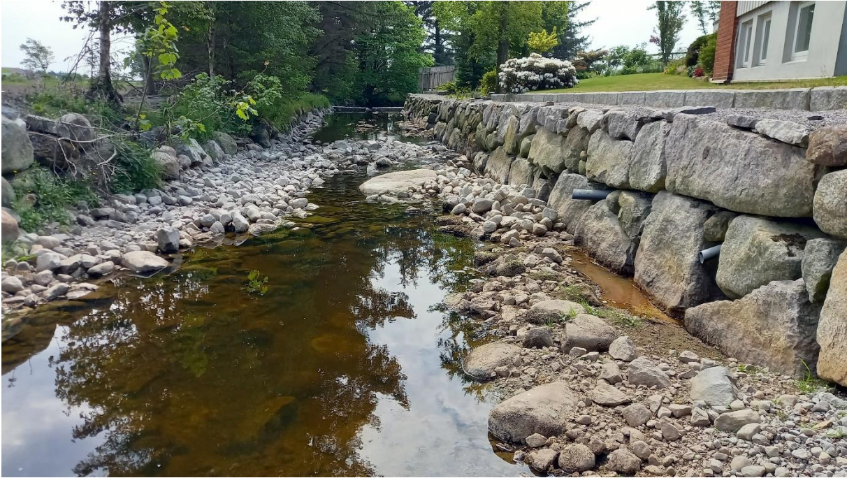
Figur 5-6. Gytegrus fra rett oppstrøms brua kan legges ut i utløpet av denne kulpen, rett nedenfor brua.
