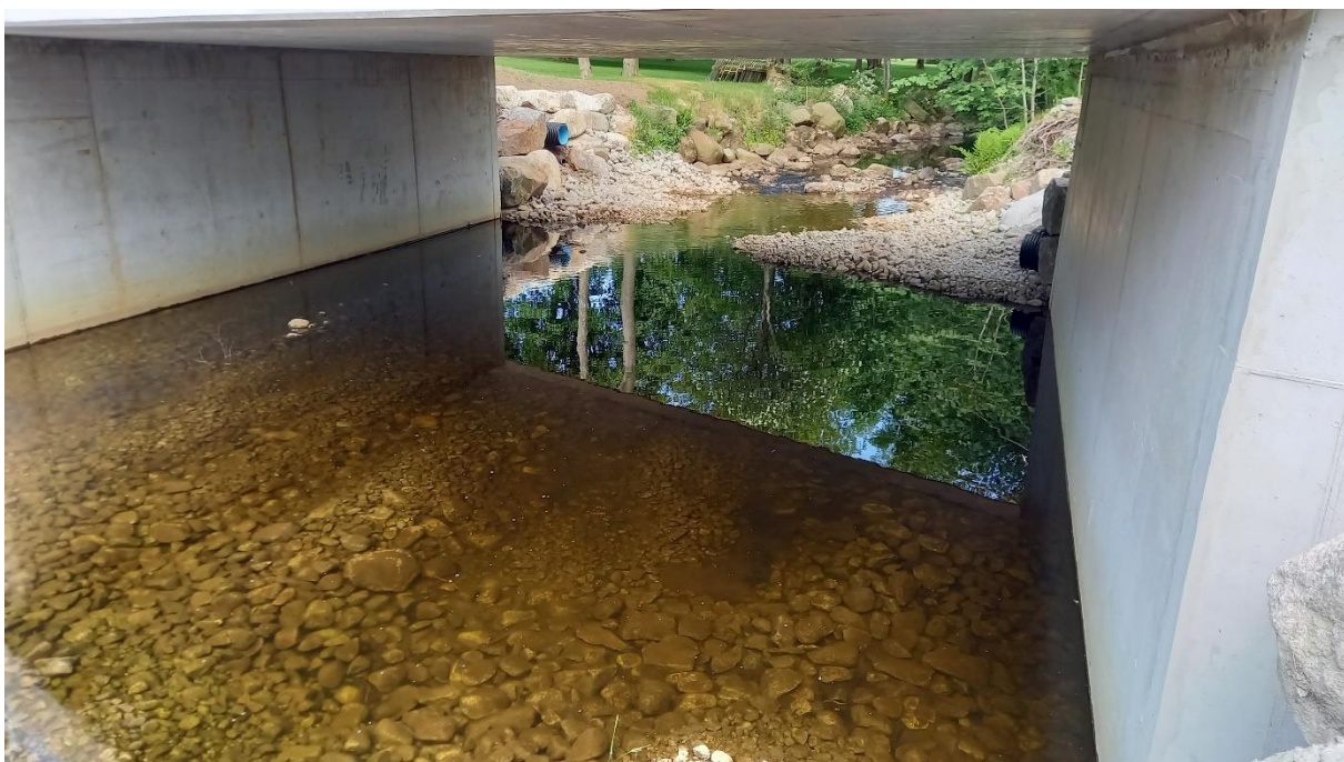
Figur 2-6. Bekkebunn under den nye brua består av stein og grus, i mindre forhøyninger. Rett oppstrøms brua er gytegrusutlegg plassert i banker, og disse utgjør i dag et lite brekk som har potensiale til å eroderes bort med neste flom.
