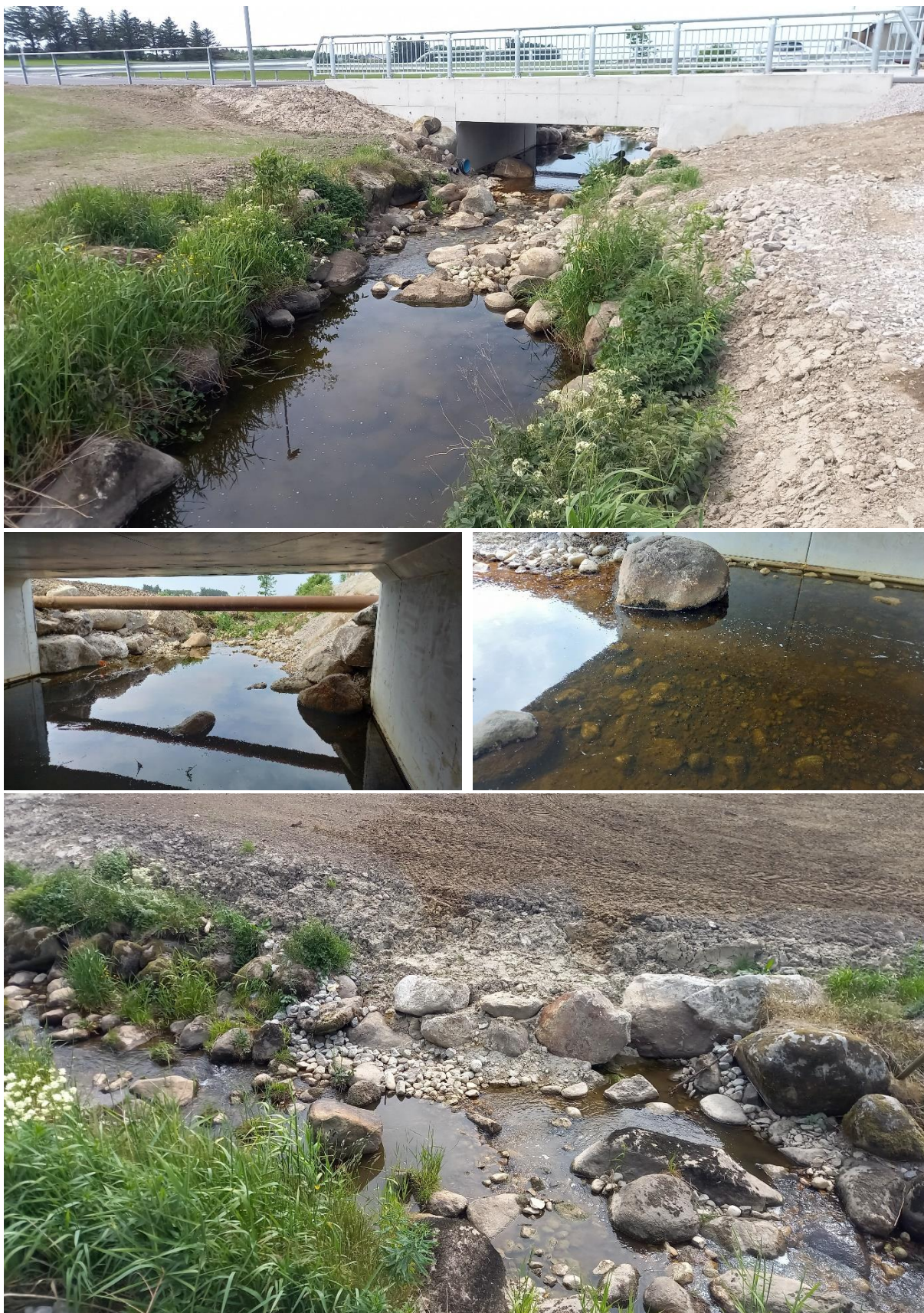
Figur 2-4. Tiltaksområdets utforming etter kulvertutbedring med et kortere strykparti (øverst), kulp med grov blokk under kulvert (midtre bilder), gytegrus i utløpssonen og strykparti nedenfor (nedre bilde). Et kort parti av bekkanten nedstrøms selve kulverten er steinsatt på ny.
