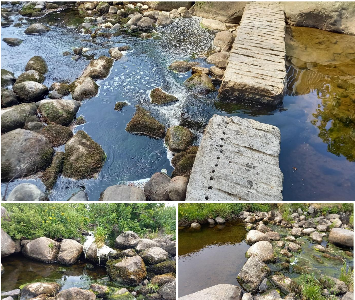
Figur V1. Vandringshinderet (V1) 50 m nedstrøms tiltaksområdet har djupål, men noe dårlig spranggrop på lav vannføring. Vandringshinder V2 (venstre) og høyre (V3).
