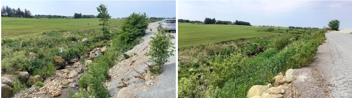
Figur 2-5. Nedstrøms tiltaksområdet går bekken i naturlig strykparti mellom stor blokk, og brei og åpen kantsone. I forbindelse med tiltaket har noe mindre stein blitt tilført sørlig halvdel av bekkeløpet i øvre del (venstre). Foruten ny kulvert er et nytt fjøs bygd på fylling på nordsida og nydyrking utført på sørsida siden 2018.
