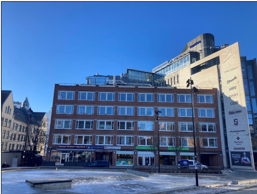
Figur 8. Taket i Fritjof Nansensvei 2 er vurdert som ikke egnet hekkeplass for byduer og det ble ikke observert reder på flyfoto.
