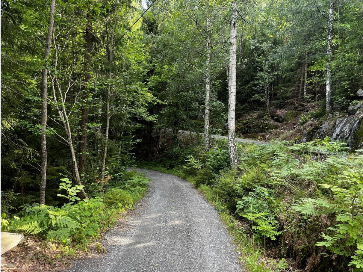
Figur 2.6. Eksisterende skogsbilvei som inngår i rørgatraseen.
