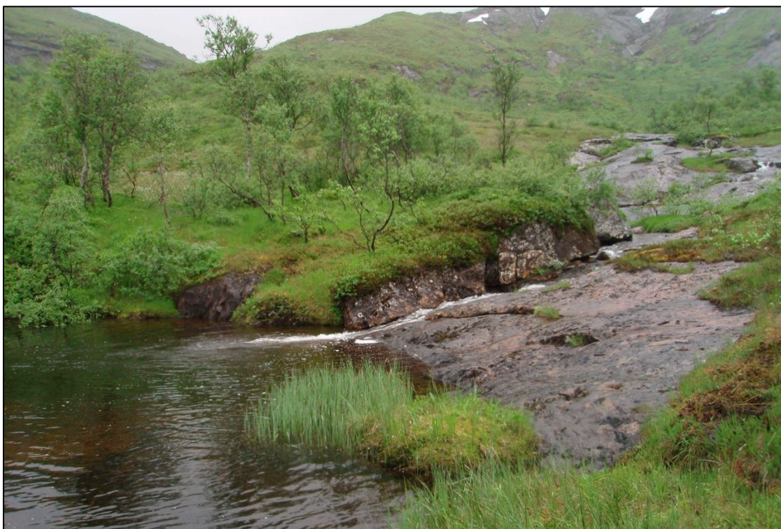
Figur 4. Sidebekk som planlegges omlagt vha. grøft til planlagt alternativ 2 inntak på kote 240. Området viser planlagt inntak til grøft fra nordvestre sidebekk. Foto: Bente Sved Skottvoll.
