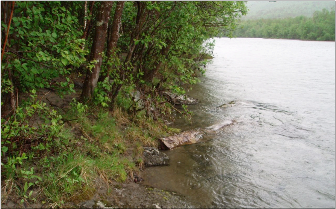
Figur 14. Elveforbygningen ned mot Rostaelva. Foto: Bente Sved Skottvoll.
